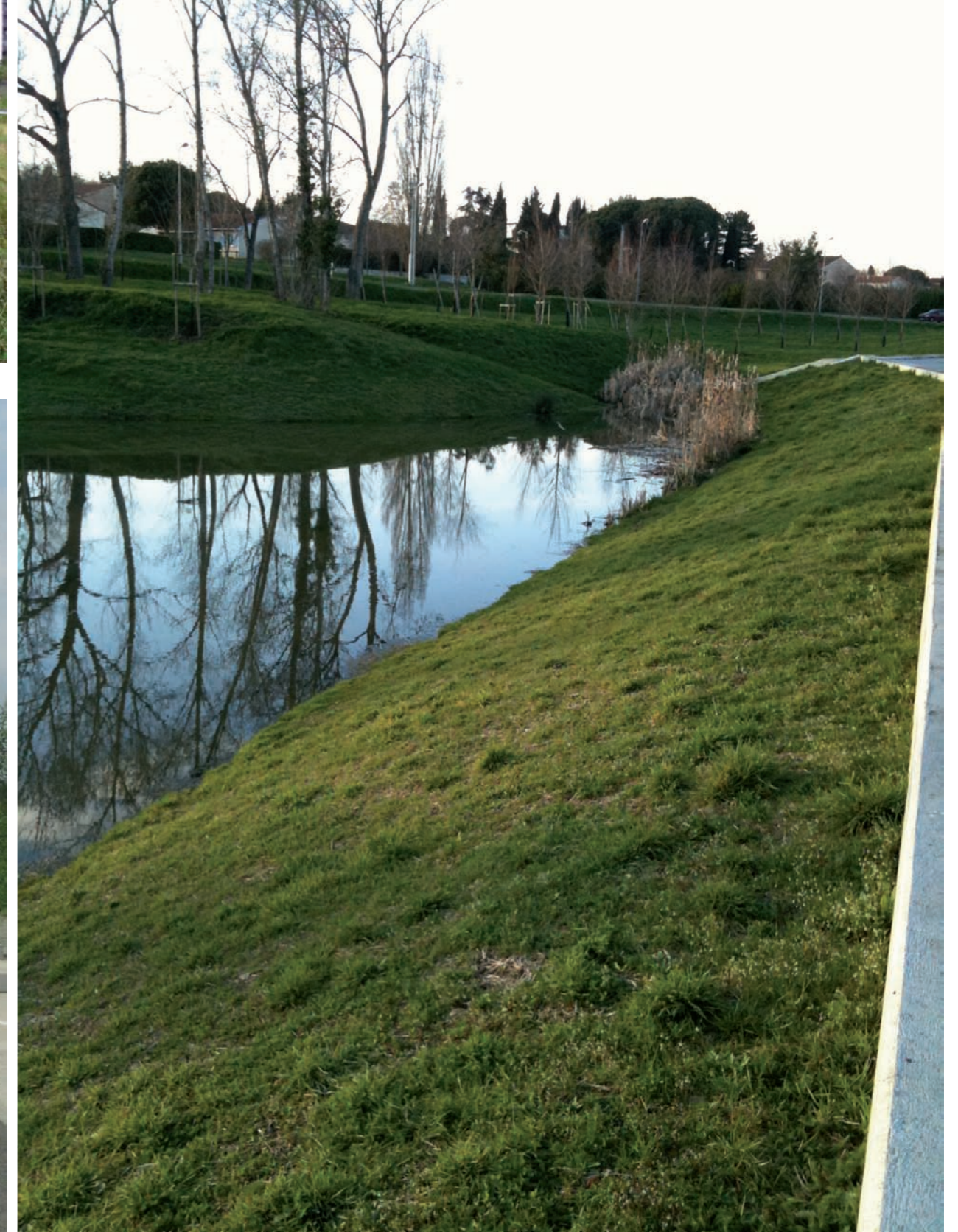
Monge Croix du Sud à Cornebarrieu, le bassin de rétention
