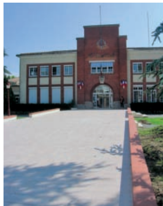
La rampe d'accès de la Mairie
