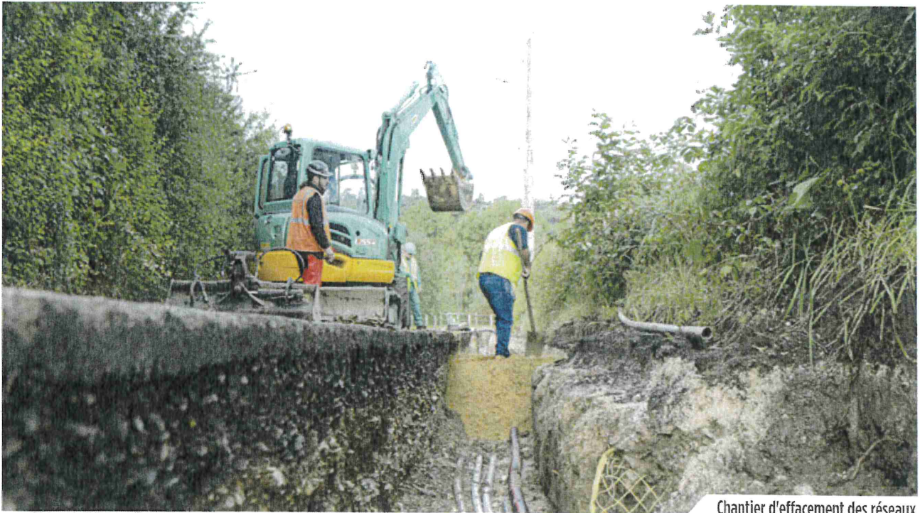
Chantier d'effacement des réseaux
