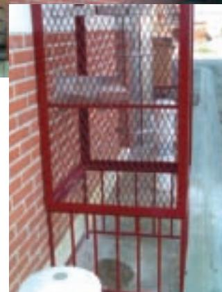
Armature de protection pour les conduits de la Salle des Fêtes
