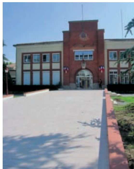
La rampe d'accès de la Mairie
