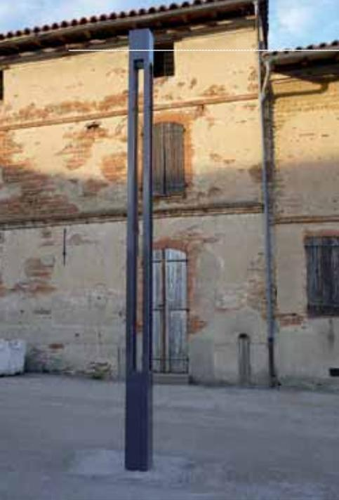
Aux extrémités de l'opération, notamment au carrefour de la rue République avec le Cours Valmy, 5 ensembles simple feu ont été installés, composés chacun d'un mât en acier de 6 mètres de haut équipé d'un appareil décoratif à source iodure métallique 70 Watts (source blanche).
