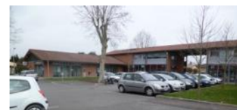
Pôle multifonction (bureaux, commerce) intégré au tissu urbain, à l'entrée de Grenade (Route Kennedy)
