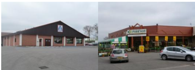
Nouveaux bâtiments à l'architecture travaillée et intégrée au tissu urbain alentour
