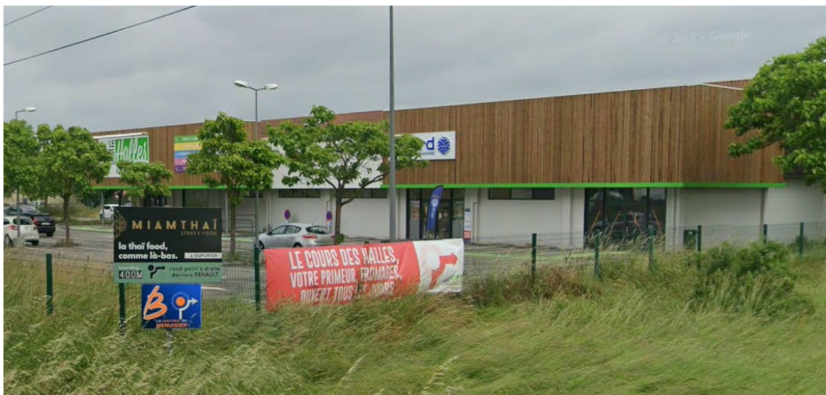
Façades bois et enduit sur les magasins en limite de la zone d'activités – Source Google maps
