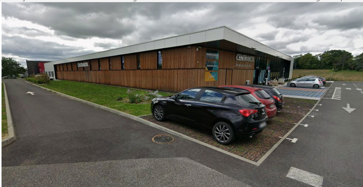
Façades bois sur le magasin Centrakor – Source Google maps Entrée sur le côté et traitement des façades continu
