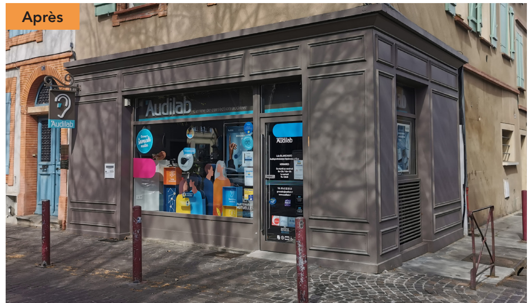
Revalorisation de la cellule commerciale par la modernisation de la devanture en applique, avec intégration esthétique du bloc de climatisation (PAC air/air).
